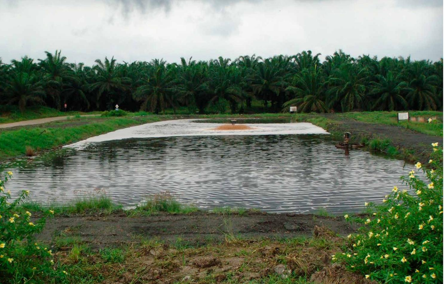
*Limbah Pabrik Kelapa Sawit dapat digunakan untuk menghasilkan biogas dan pupuk organik. Kubangan Limbah Pabrik Kelapa Sawit Palm Oil Mill Effluent (POME) di Sabah, Malaysia (Gambar: Oliver Pye)*
