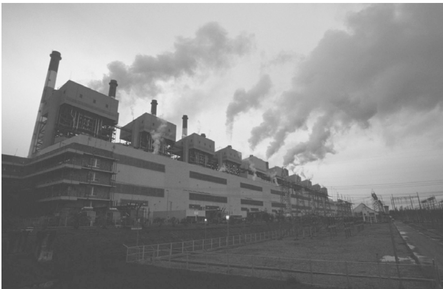
Das Mae-Moh-Kohlekraftwerk in Nordthailand
