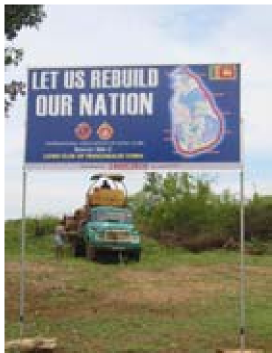
Baustelle für eine Siedlung für Flutopfer in Trincomaleer
