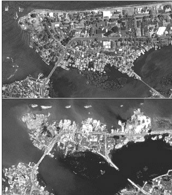
Die Satellitenaufnahmen belegen die Zerstörung. Oben vor dem Tsunami, unten nach dem Tsunami. Mit den Teilen der Küste sind auch Menschen, Tiere, Häuser und Straßen weggerissen worden.
