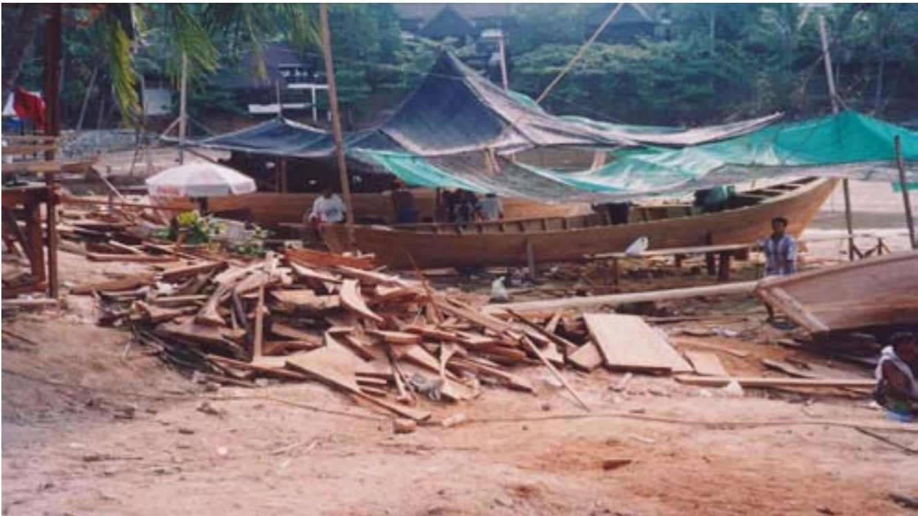
Restaurierung von Fischerbooten am Strand von Kamala
