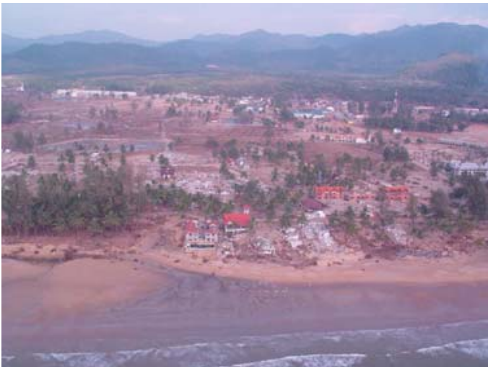
Zerstörte Hotelanlagen in Khao Lak
